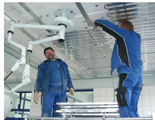
Montage der Deckenstrahlheizung.
