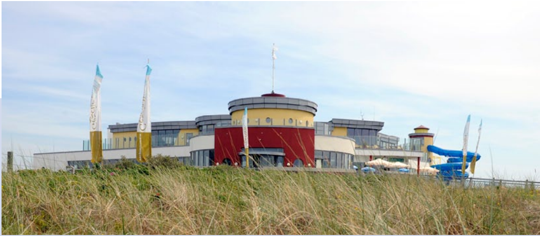
Große Leistung: Drei Gas-Brennwert-Heizkessel Logano plus GB402 liefern Heizwärme und warmes Wasser für das Meerwasser-Erlebnisbad „Gezeitenland“ auf Borkum. Seite 6
