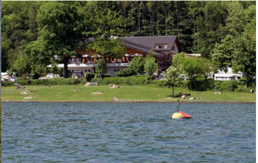
Eine Boje im See markiert die Entnahmestelle des Wassers für die Wärmepumpe. Diese versorgt das Gebäude im Hintergrund, in dem sich das Restaurant und die sanitären Einrichtungen für die Campinggäste befinden, mit Heizwärme und warmem Wasser.
