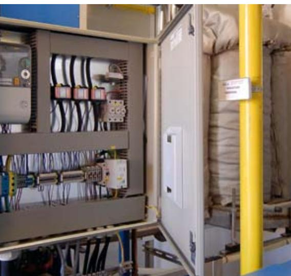
**Die elektrischen** Anschlüsse sind am mobilen BHKW modul DN50 fest installiert.
