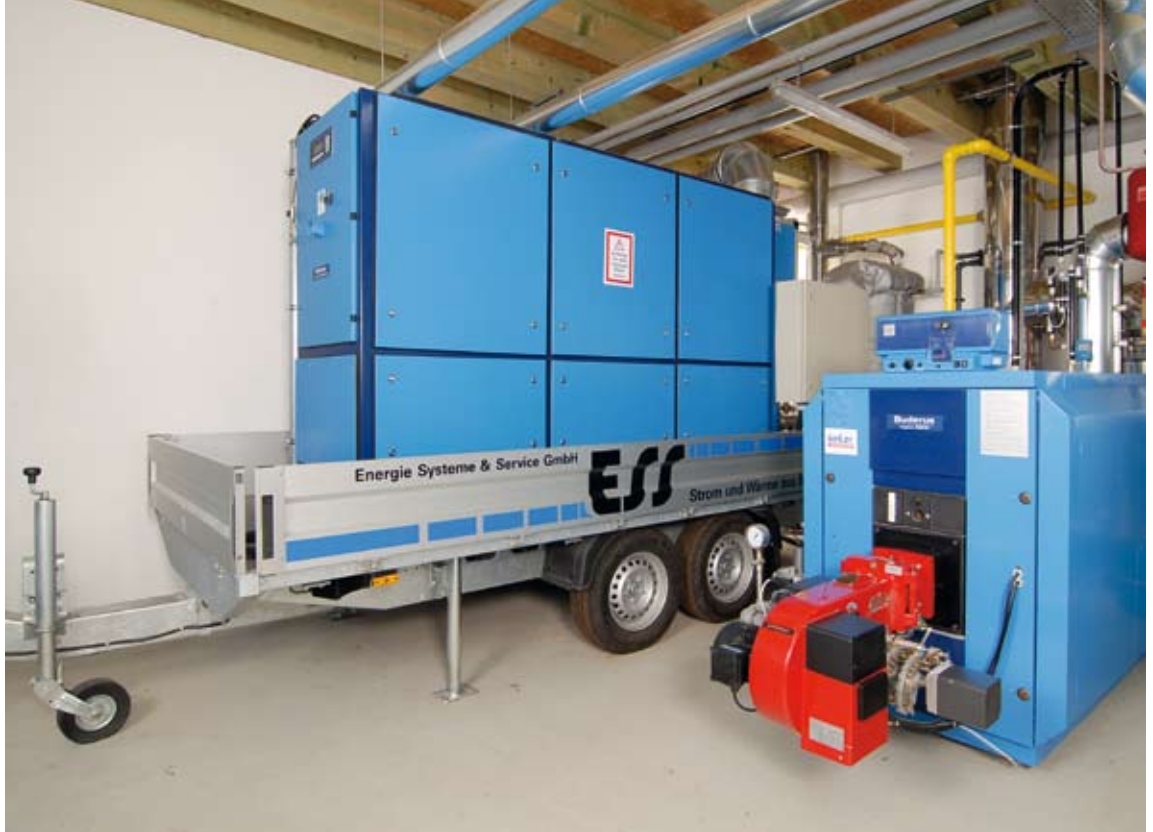
Für den Transport des Loganova BHKW Modul wurde ein passgenauer Anhänger gebaut.
