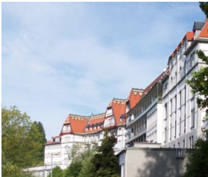
Bevorzugte Wohnlage: Die denkmalgeschützten Gebäude einer ehemaligen Lungenheilanstalt werden heute als attraktives Wohn- und Geschäftszentrum genutzt.
