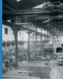
Montage von Großkesseln (um 1928)
