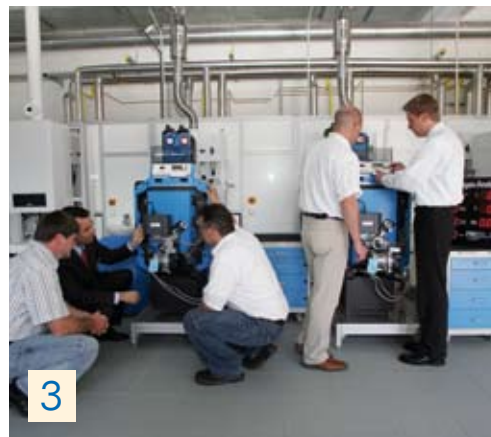
Mehrere gleiche Öl- und Gas-Heizkessel sind für Praxis-Schulungen aufgestellt.
