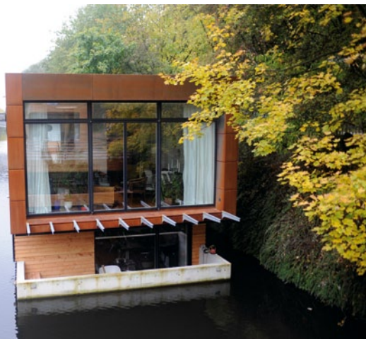
Ein Hausboot in Hamburg wird von einer Sole/Wasser-Wärmepumpe mit Heizwärme und warmem Wasser versorgt. Als Wärmequelle dient das Flusswasser, unter dem Ponton verlaufen 150 Meter Rohrschlangen. Seite 20
