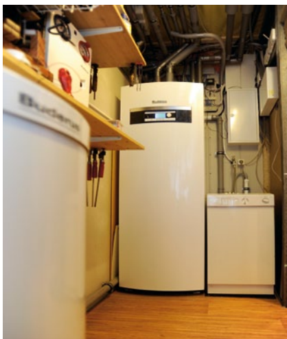
Auf engstem Raum findet die Wärmepumpe Logatherm WPS K Platz.
