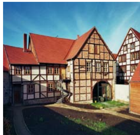
Mit dem Denkmalpreis wurde die Firma HEISAT nach der Renovierung des „Höllenhofs“ geehrt.
