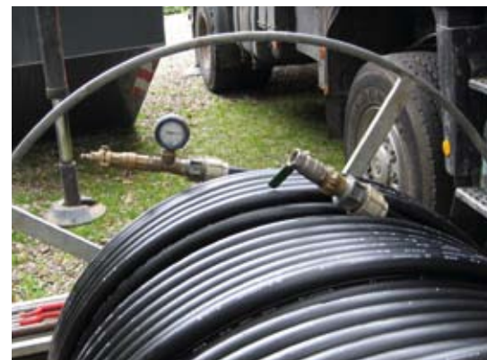
Auf dem Kiesparkplatz vor dem Wohngebäude musste die Firma Stoltenberg Energie GmbH besonders sorgsam arbeiten.
