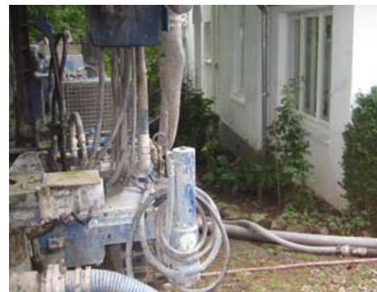
Drei Erdsondenbohrungen von jeweils 100 Meter Tiefe waren für die erforderliche Heizleistung nötig.
