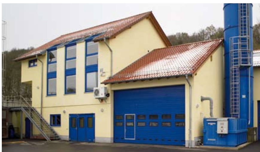
Die Kläranlage der Gemeinde Baumholder kann mehr: Eine Sole/Wasser-Wärmepumpe nutzt die Temperatur des Abwassers zur Raumbeheizung und Trinkwassererwärmung.
