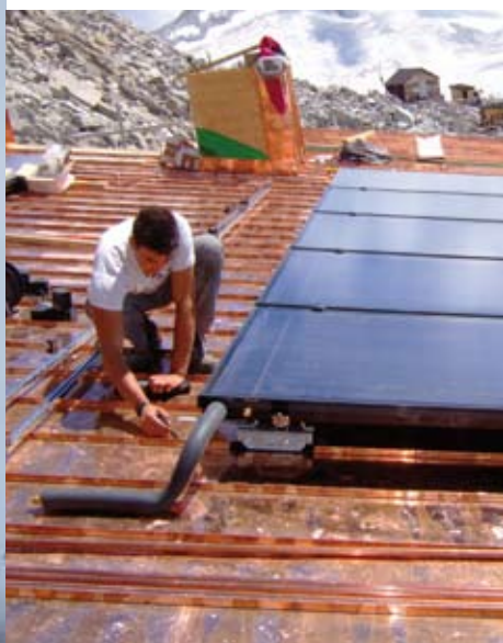
Der Sonne entgegen: Heizungsfachleute montieren Sonnenkollektoren auf einer Berg-hütte in den italienischen Alpen in etwa 3 000 Metern Höhe.
