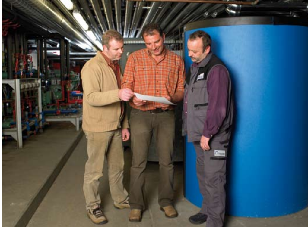
Gute Teamleistung (von links): Stefan Schmitt (Obermonteur Firma Nölke), Jürgen Berend (Abteilungsleiter Haustechnik Firma Nölke) und Joachim Schneider (Technischer Leiter der Universität Kaiserslautern).
