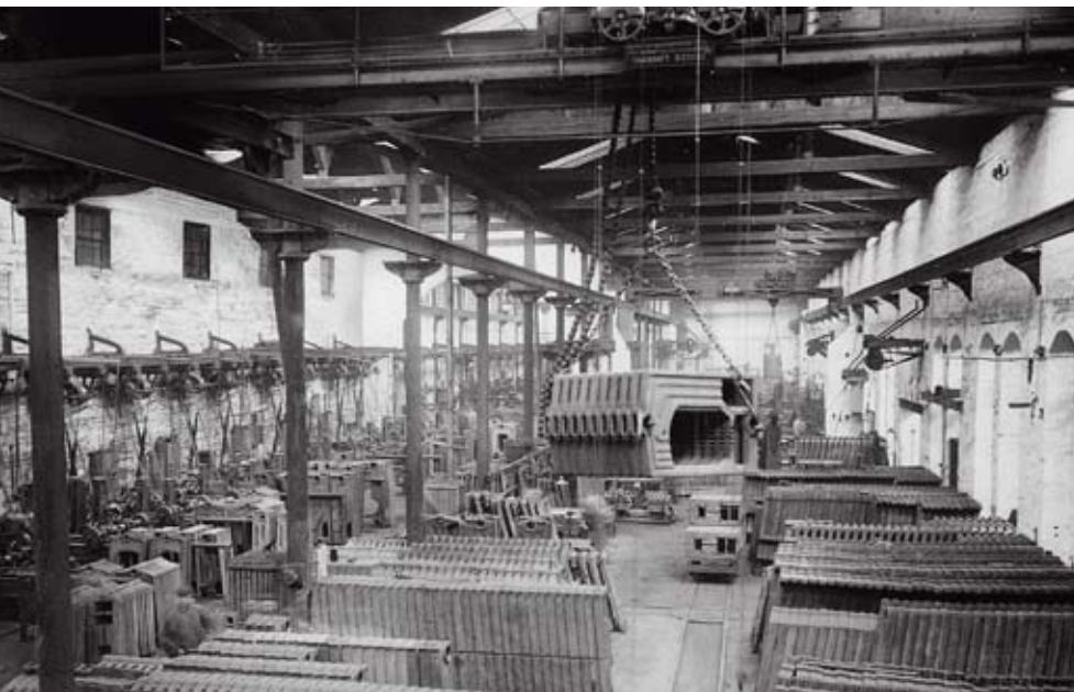
Um 1928: Bearbeitung und Montage von Heizkesseln in der Main-Weser-Hütte. Die Bearbeitung der Kesselglieder bestand aus dem Schleifen der Glieder an den Dichtleisten beziehungsweise Flanschen und dem Fräsen der Naben.
