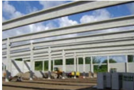
Eine Stahlträger-Konstruktion überspannt den gesamten Bereich der Lagerhalle.
