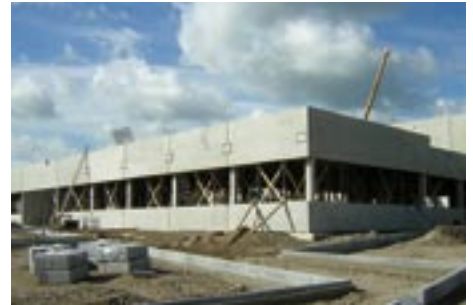
Gutes Wetter hat die Bauarbeiten begleitet. So konnte der Zeitplan eingehalten werden.
