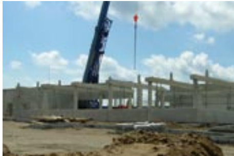
Der Neubau wächst: Nach nur zwei Monaten stand der Rohbau.
