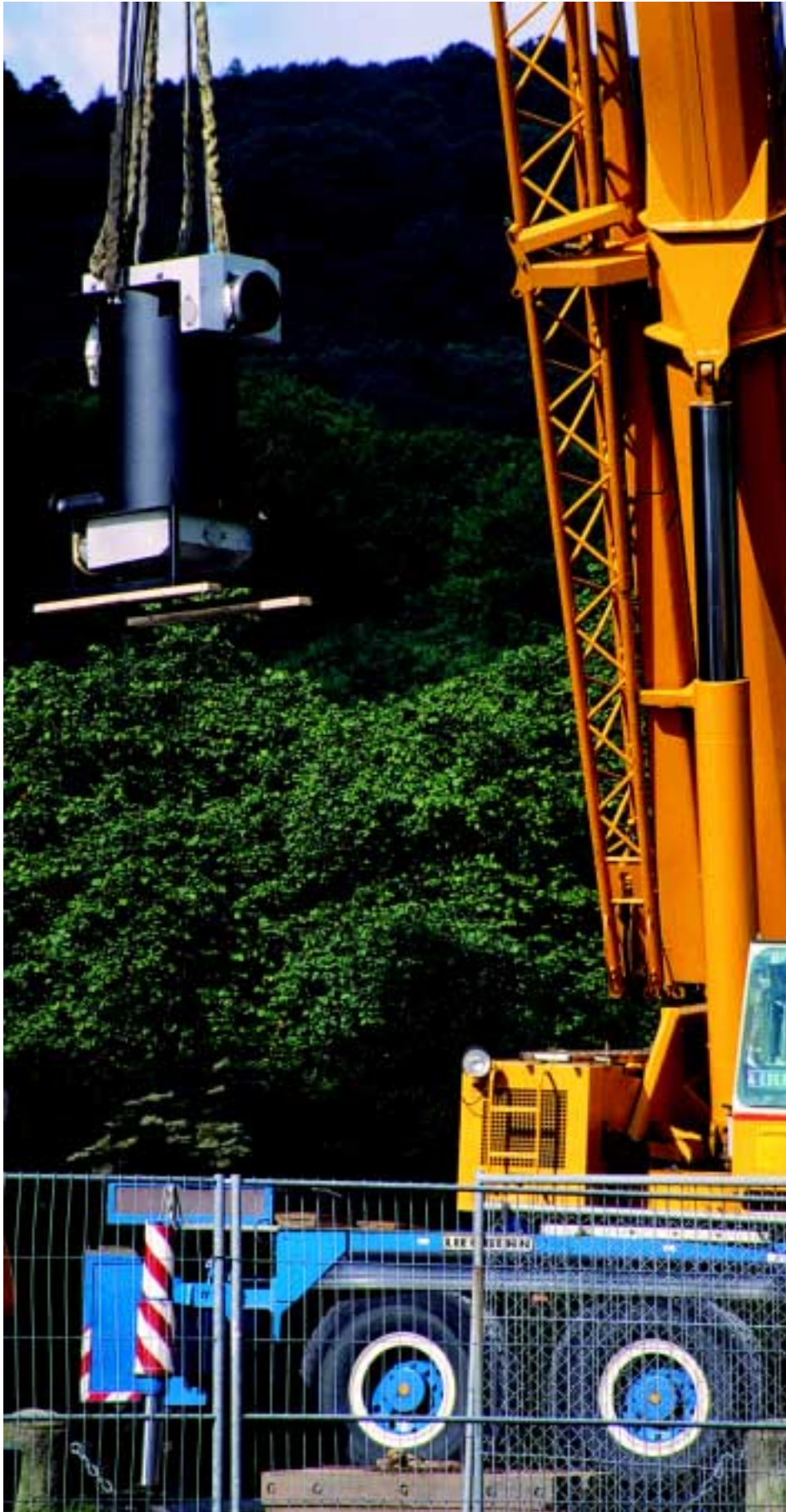
Ein schwarzer Zylinder schwebt ein: Der Abgaswärmetauscher, der später dem Brennwertkessel nachgeschaltet wird.
