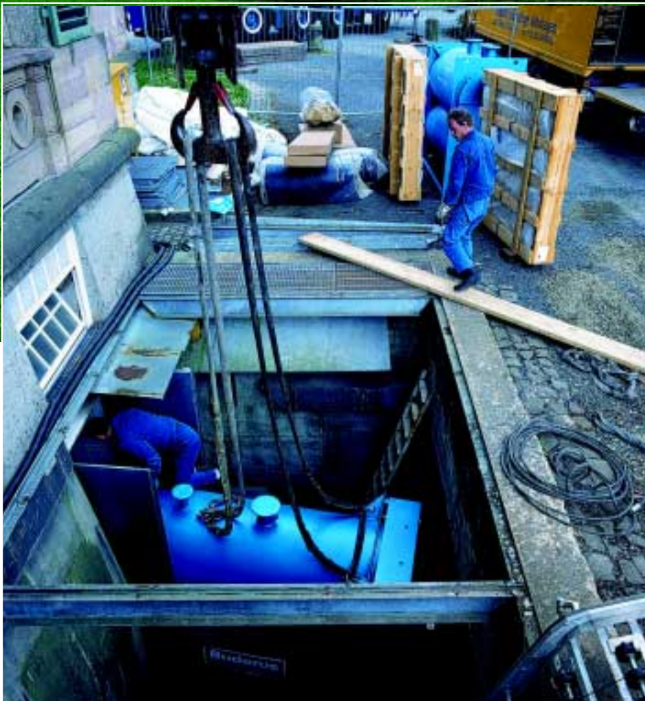
Zum reibungslosen Abladen des Großkessels ist viel Fingerspitzengefühl erforderlich.
