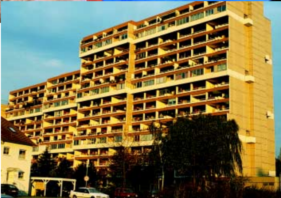
Rund 500 Wohnungen in diesem Hochhauskomplex erhalten ihre Wärme jetzt von einer hochmodernen Heizzentrale.
