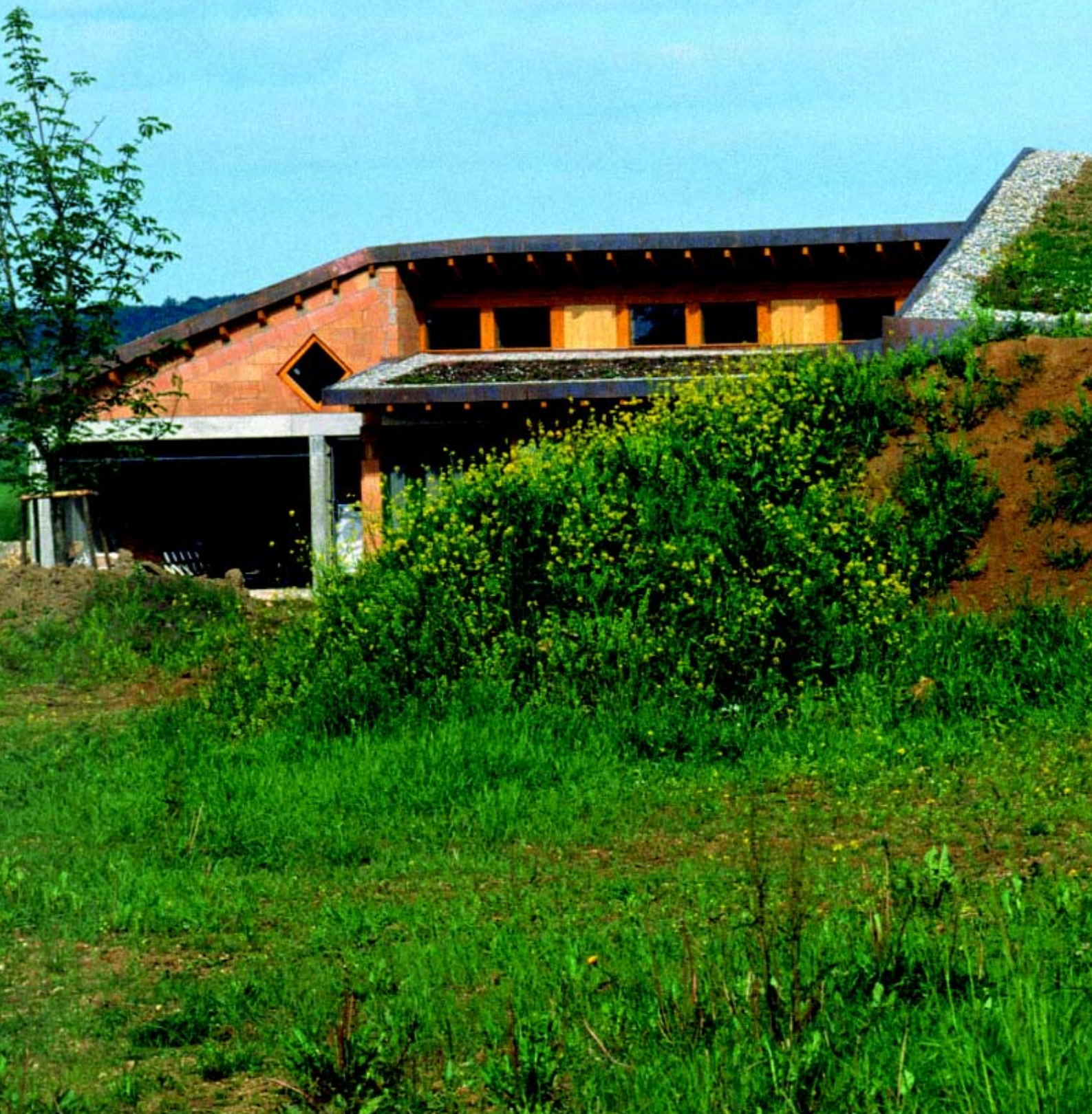
Schon von weitem wird der besondere Charakter des „Lehmhauses“ deutlich.
