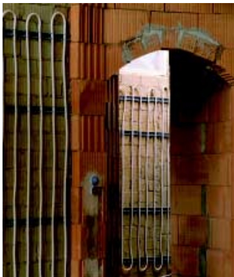
Insgesamt über 2.000 m Verbundrohr wurden für die Wandheizung installiert.
