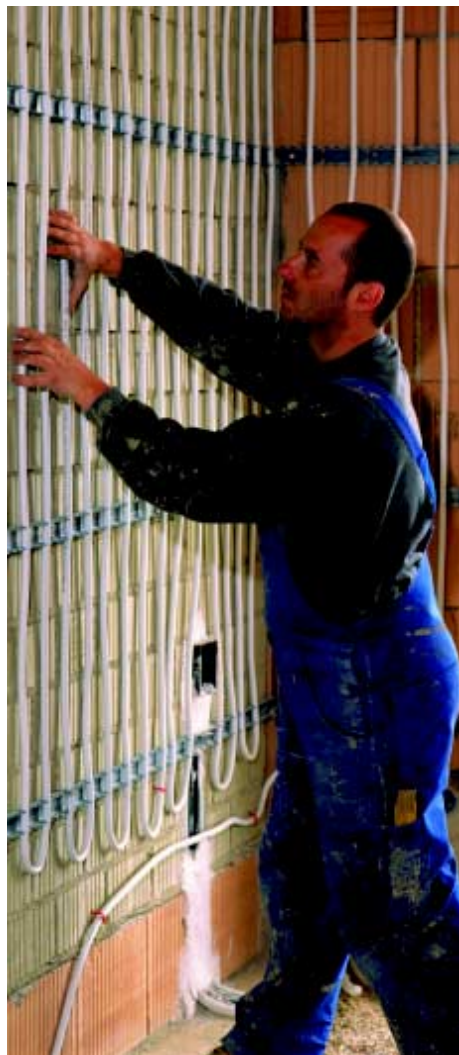
Die Verlegung der Verbundrohre erfordert viel Sorgfalt und handwerkliches Know-how.
