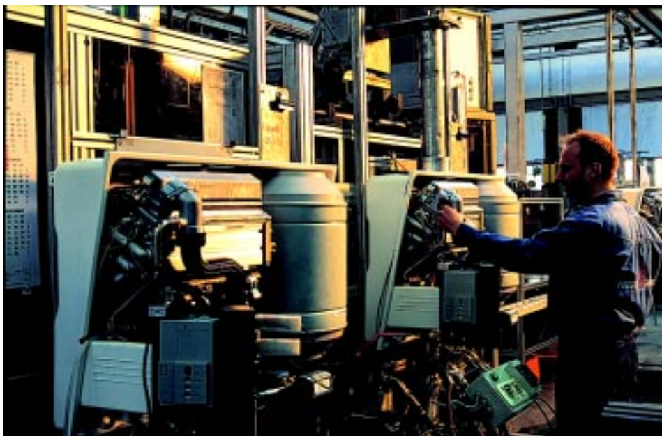
Jetzt dauert es nicht mehr lange, bis die wandhängenden Brennwertkessel einsatzbereit sind.
