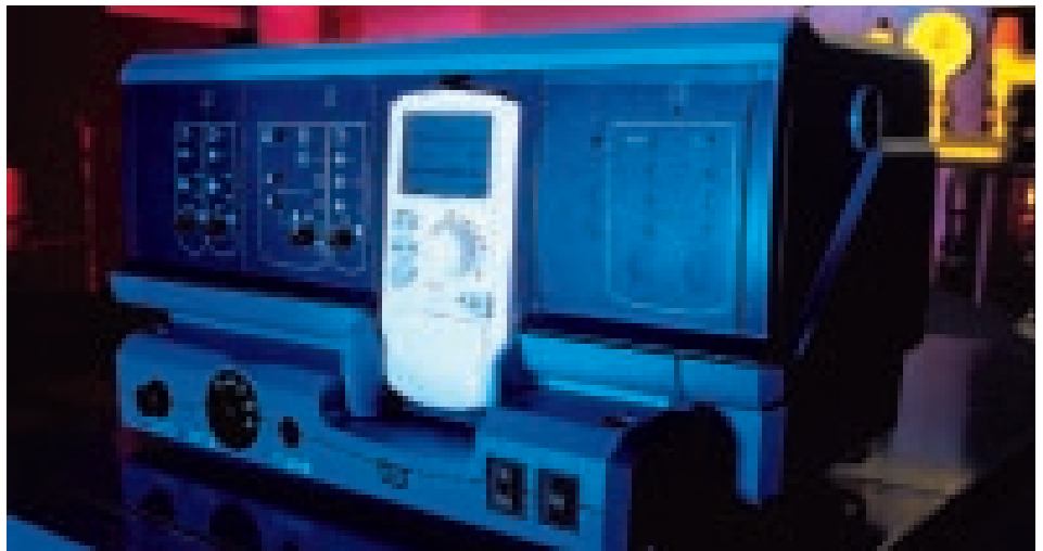
Regelung auf höchstem Niveau: Das Regelgerät Logamatic 4211 mit dem Funktionsmodul FM 442 und dem EIB-Modul FM 446 übernimmt die wärmebedarfsgeführte Regelung einer Einkesselanlage mit drei Heizkreisen sowie einem Warmwasser-Speicher mit Zirkulationspumpe.
