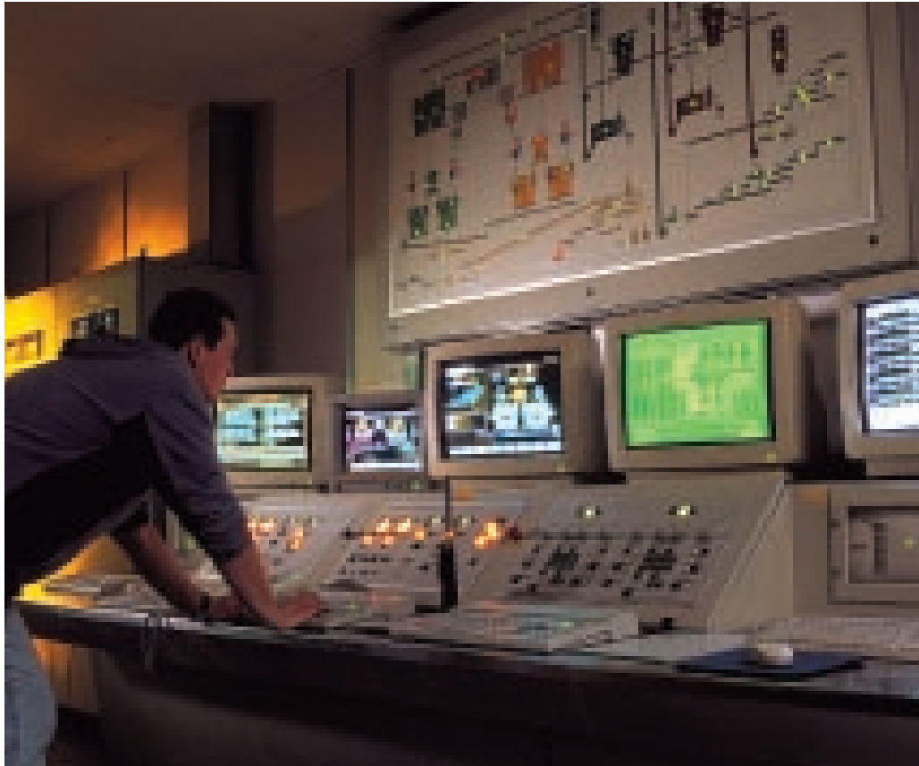
Ein Hauch von „Raumschiff Enterprise“: In der Schaltzentrale für die Sandaufbereitung und die Formstoffaufbereitung wird die Qualität des Materials permanent mit modernster Computertechnik überwacht.
