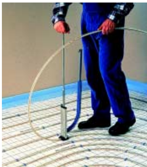
Mühevolle Handhabung: das neue Turbo-Tacker-System von Buderus.
