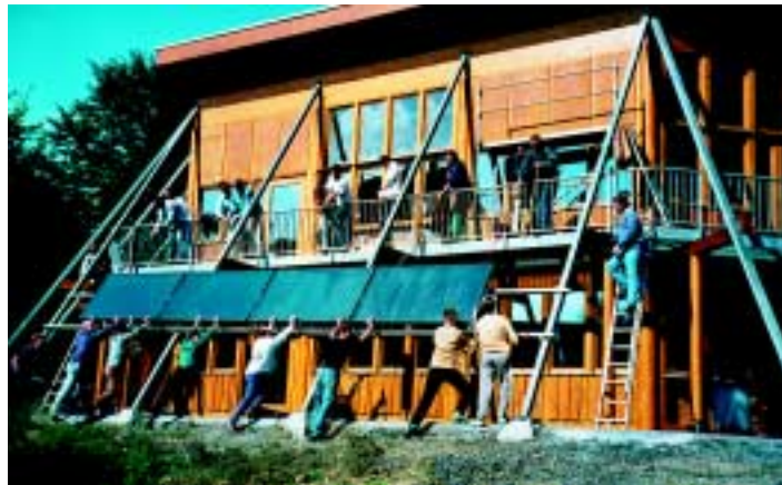
Montage der solarthermischen Kollektoren von Buderus durch Studierende.
