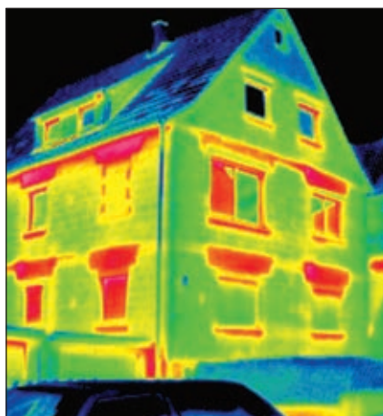
Außenthermographie (Quelle: Flir Systems GmbH)
