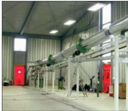
BlowerDoor-Messung in einer Industriehalle (Quelle: BlowerDoor GmbH)
