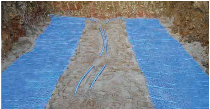
Verlegung des Kompaktkollektors
