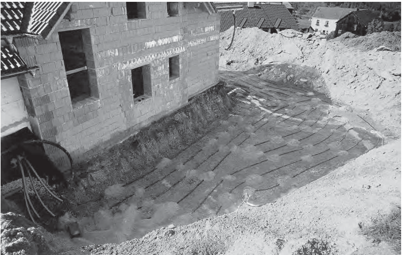
Erdkollektor vor dem Einsanden
