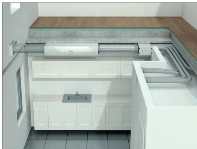
Abb 43: Einbaubeispiel kombinierter Luftverteiler/-sampler
