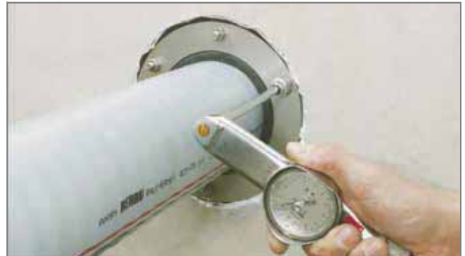
Abb. 159: Montage mit Drehmomentschlüssel
