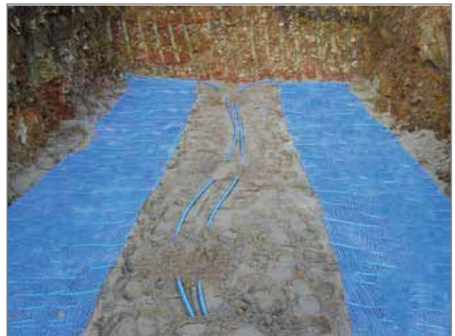
Abb. 85: Verlegung des Kompaktkollektors
