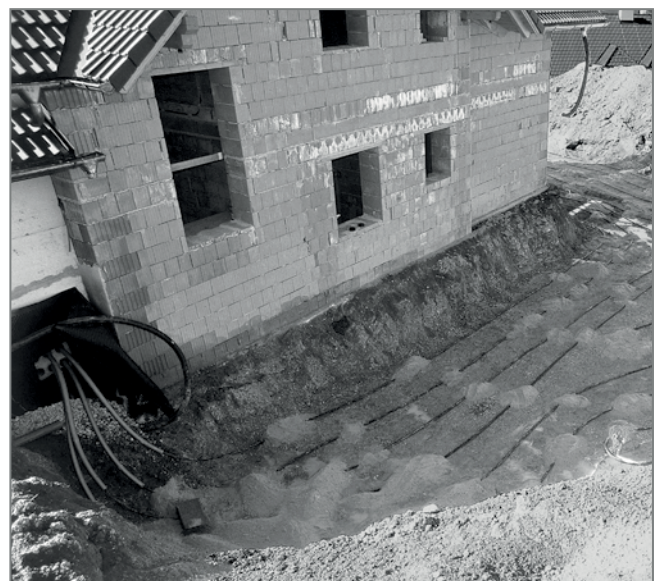
Abb. 83: Oberflächennaher Erdkollektor vor dem Einsanden
