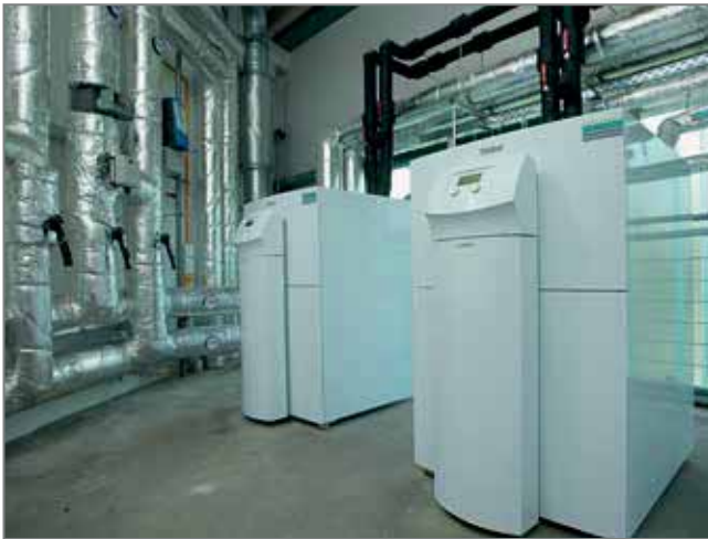
Abb. 37: Kaskadenlösung zur zentralen Beheizung
