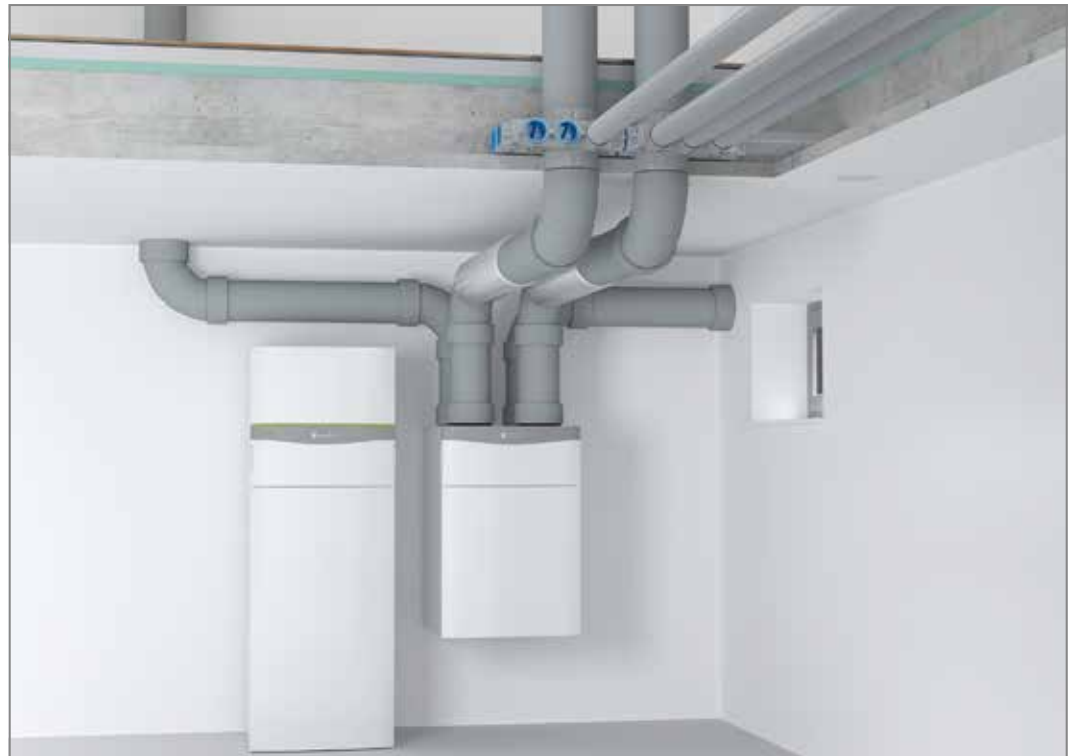
Abb 22: Installation im Keller
