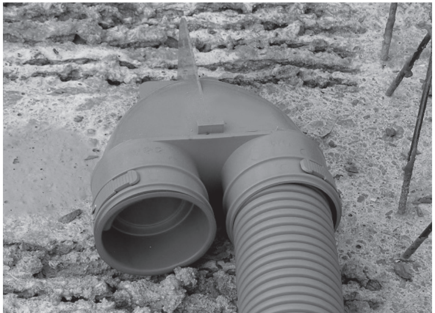
Schutz vor Verschmutzung durch Hygieneverschlüsse für alle Komponenten
