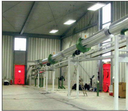
BlowerDoor-Messung in einer Industriehalle (Quelle: BlowerDoor GmbH)
