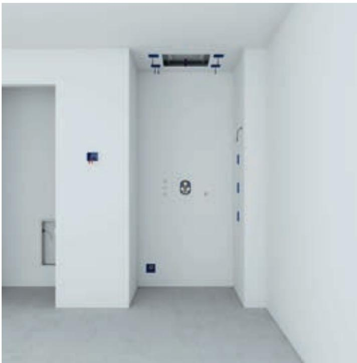
Achten Sie bei der Verkleidung der Wände bitte darauf, dass die Kabelenden in der gewünschten Position bleiben. Ansonsten ist der Anschluss der Module nicht möglich.
