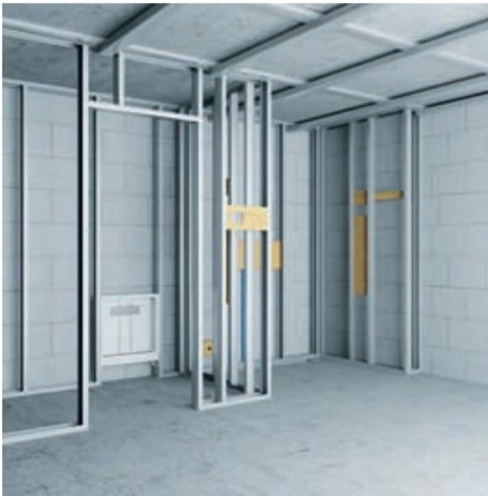
Übersicht zum Aufbau der Leichtbau-Ständerwand für die Dusche und zum Nebenraum.
