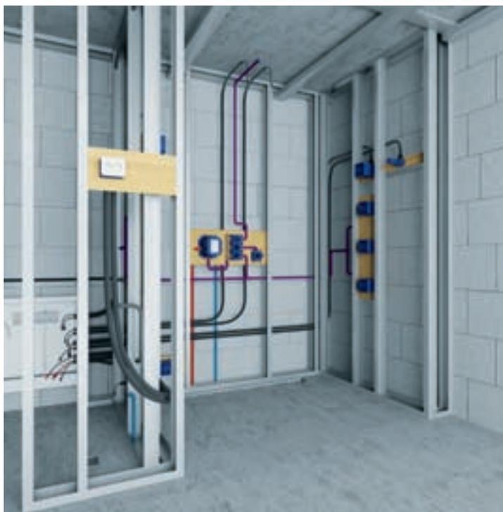
Installieren Sie zunächst die Unterputz-Elemente für die Armaturen und Seitenbrausen.
