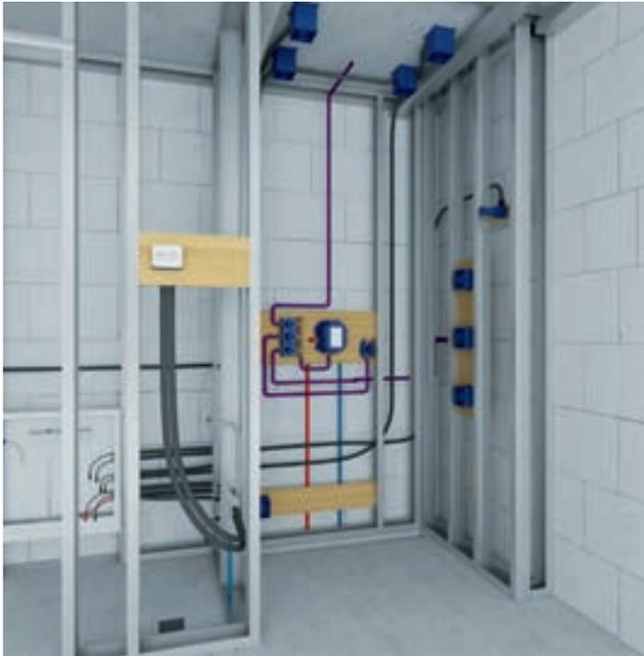
Installieren Sie zunächst die Unterputz-Elemente für die Armaturen und Seitenbrausen. Verbinden Sie sie mit den Kalt- und Warmwasseranschlüssen und den Versorgungsleitungen.
