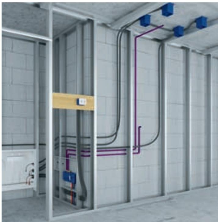
Installieren Sie zunächst die Unterputz-Elemente für die Armaturen. Verbinden Sie sie mit den Kalt- und Warmwasseranschlüssen und den Versorgungsleitungen.
