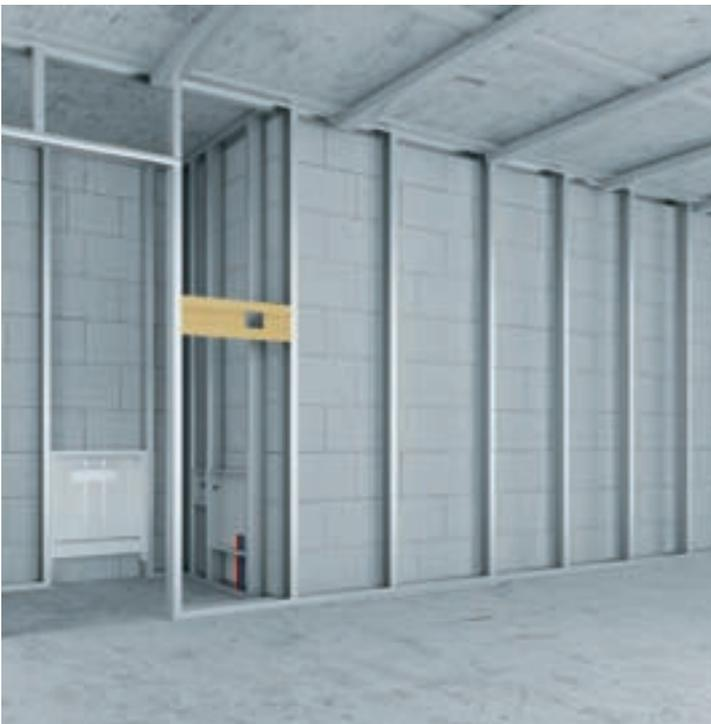
Übersicht zum Aufbau der Leichtbau-Ständerwand für die Dusche und den Technikraum. Befestigungsplatte für Docking-Station.
