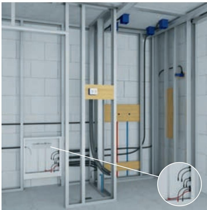
Um die Unterputz-Module korrekt anschließen zu können, planen Sie bitte eine Kabel-Überlänge von mindestens 20 cm ein.
