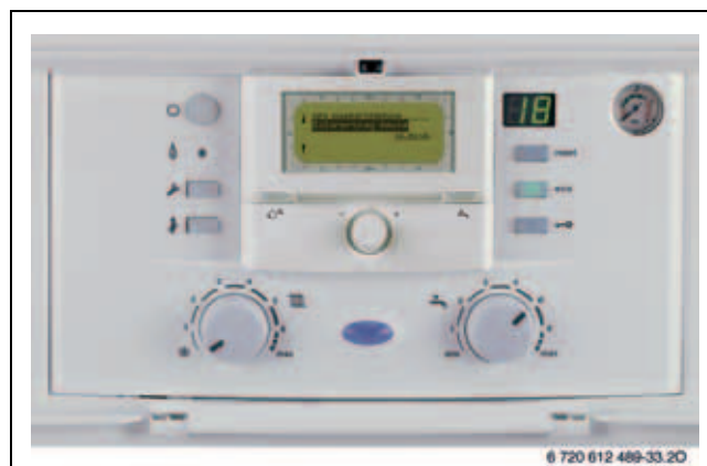
Bild 104 Heatronic 3 mit eingebautem witterungsgeführten Regler
