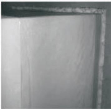
Anschließend die Hohlräume zwischen den Luftkanälen und dem Mauerwerk mit Montageschaum ausschäumen.
