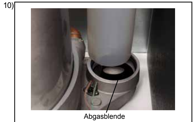
Abgasblende Ø 53 mm in die Kondensatwanne einlegen und Abgasrohr wieder hineinschieben.
