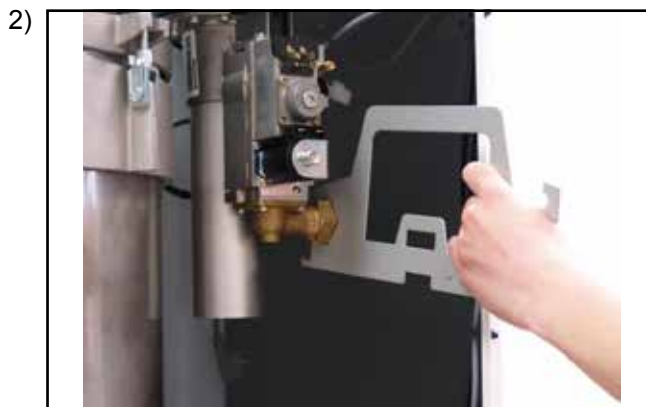
Verschraubung Gasanschluss am Gaskombiventil lösen
