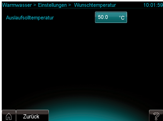
Abb. 8.14 Anzeige Wunschttemperatur Warmwasser einstellen
