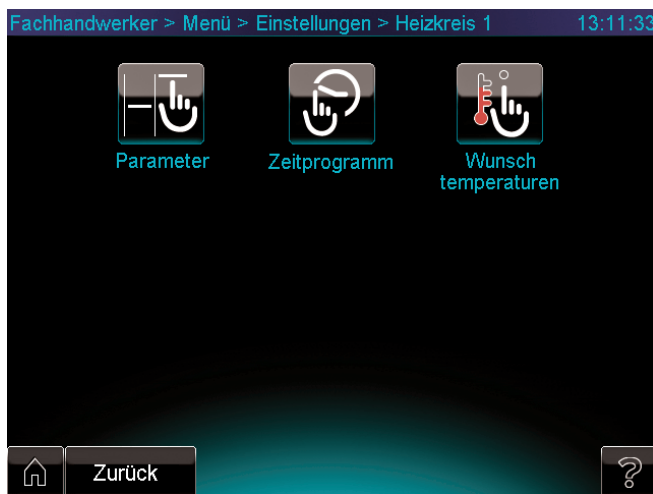
Abb. 6.16 Anzeige Einstellungen Heizkreise (hier Heizkreis 1)
