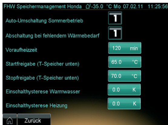
Abb. 6.10 Display Speichermanagement KWK-Modul
