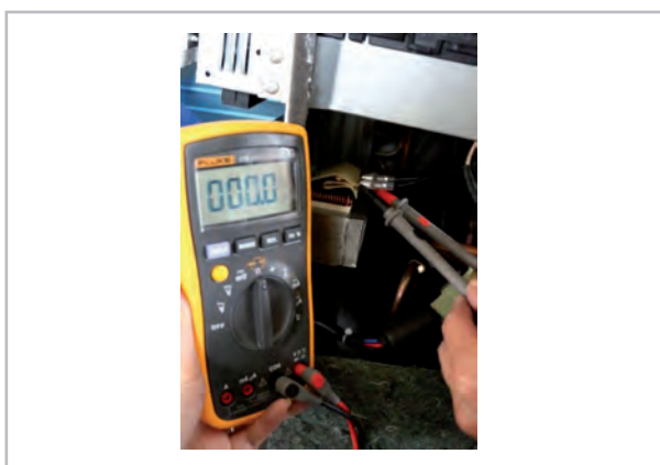
Abb. 46: Messung des Transformators
