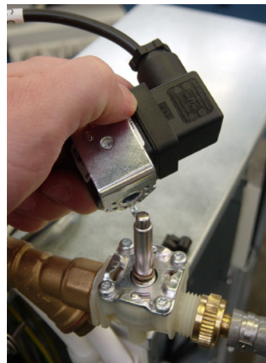
Retirada de la bobina
