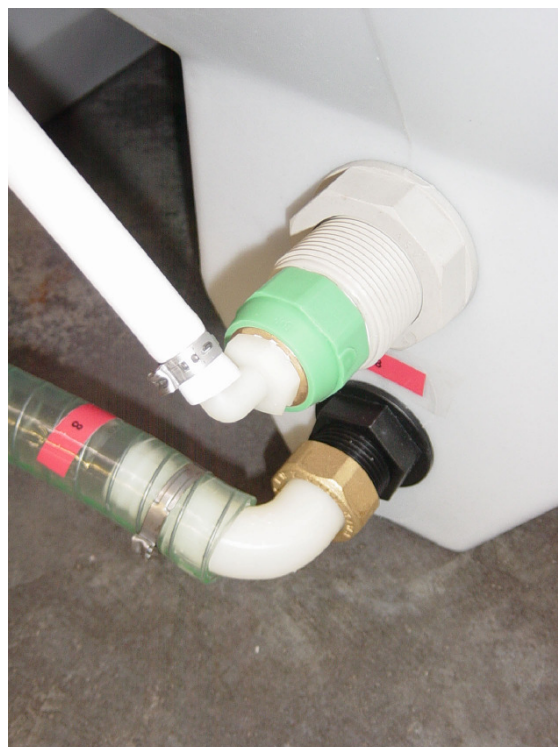
attacco gruppo ventilatore
