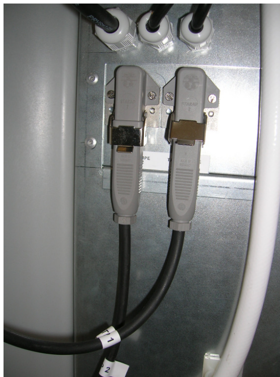
connettore delle pompe ad immersione
