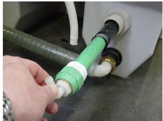
Desmontaje de la unidad de ventilación
