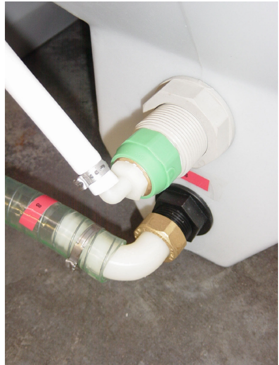
Conexión de la unidad de ventilación
