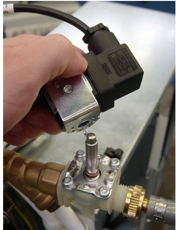
Desmontar la bobina
