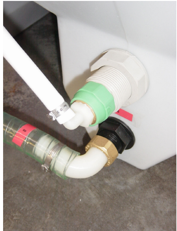
Anschluss Belüftereinheit
