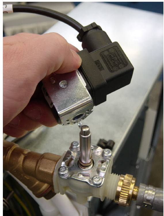
rimozione della bobina
