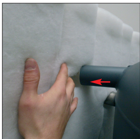
3 Isoliermantel dem Speicher anlegen und die Speichermuffen exakt durch die vorgestanzten Löcher führen (bei den ungenutzten Ausstattungen sollten die Schaum-Stopfen nicht entfernt werden!)
