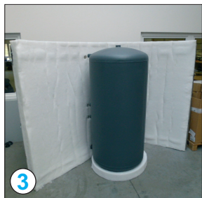
3 Isoliermantel dem Speicher anlegen und die Speichermuffen exakt durch die vorgestanzten Löcher führen (bei den ungenutzten Ausstattungen sollten die Schaum-Stopfen nicht entfernt werden!)
