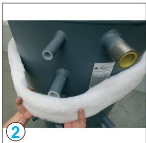
2 äußere Standringisolierung von oben nach unten...
