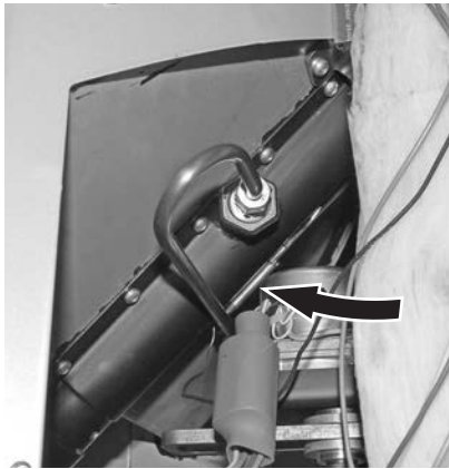
Fig.15 Fühler für Sicherheitsthermostat-Schneckenrohr ganz einschieben
