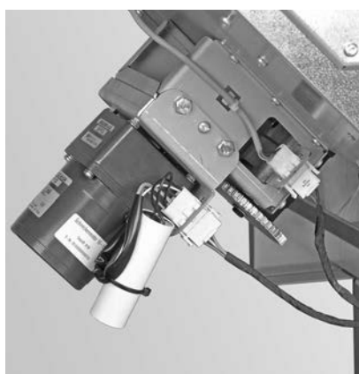
Fig. 19 Enchufar los conectores del motor y el sensor de proximidad
