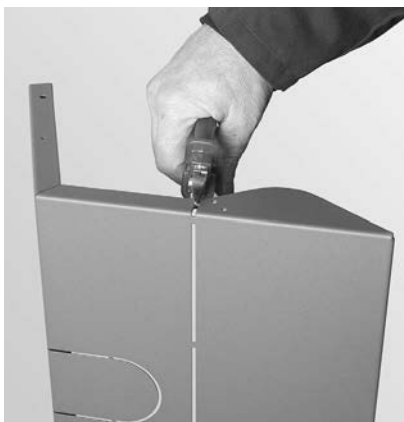
Fig. 26 Cortar el alma en la parte superior e inferior
