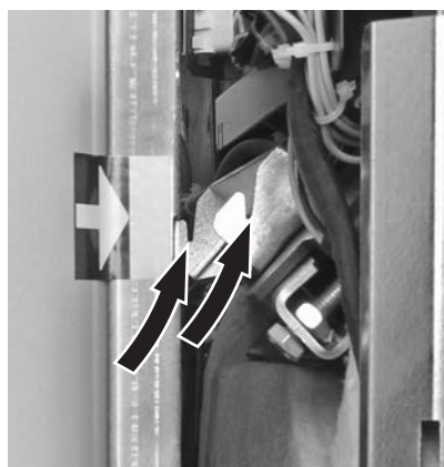
Fig. 11 Enganchar el contenedor para una semana 2 veces en el lugar que indica la marca
