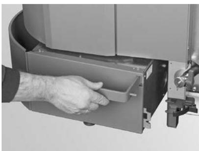
Fig. 32 Aschebox leicht nach links drücken
