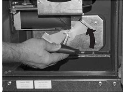
Fig. 29 Griff verdrehen gegen den Uhrzeigersinn verdrehen
