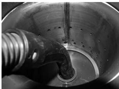
Fig. 47 Primärluftrohr in der Mitte des Brennerkopfes aussaugen
