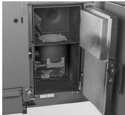
Fig. 25 Verkleidungstür und Brennraumtür öffnen
