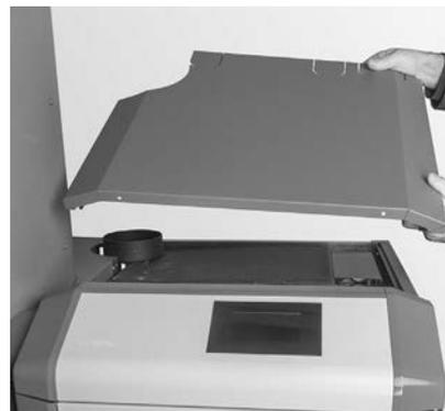
Fig. 50 Abdeckung oben abheben
