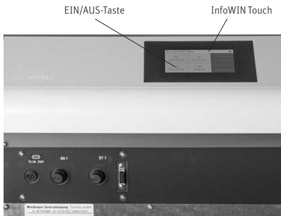
Fig. 14 Kessel BioWIN 2 Touch mit InfoWIN Touch
