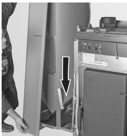
Fig. 64 Blende nach unten schieben und abnehmen (Bajonettverschluss)
