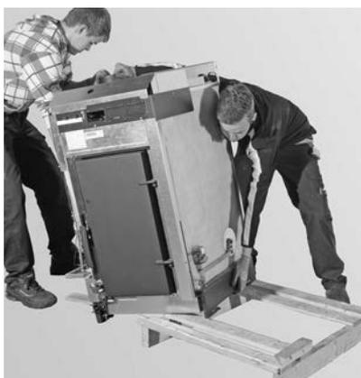
Fig. 12 Kessel von Palette schieben
