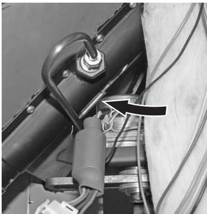
Fig. 39 Fühler für Sicherheitsthermostat-Schneckenrohr ganz einschieben
