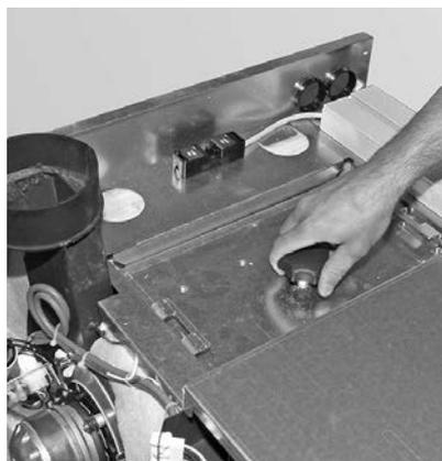
Fig. 24 Verschraubung entfernen
