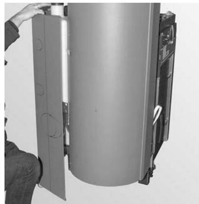
Fig. 50 Klebebänder von Wasserbehälter entfernen und Verkleidung einhängen
