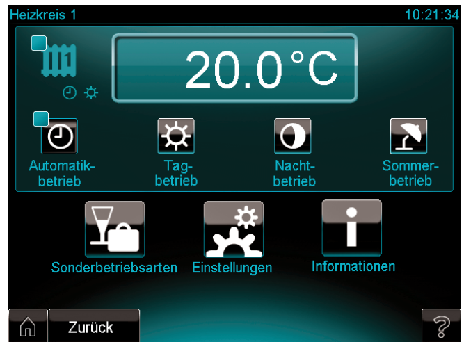
Abb. 5.14 Komponenten-Anzeige: Heizkreis (hier: Heizkreis 1)
