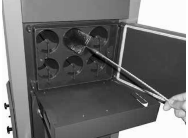
Reinigung der Rohrwand
