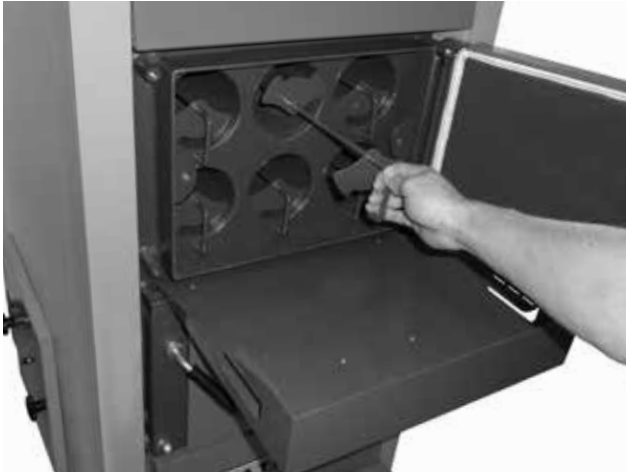
Reinigung der Rohrwand mit Hilfe des Schürhakens
