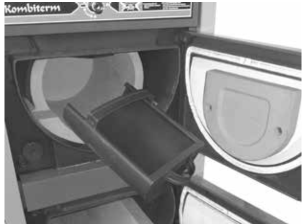
Geöffneter Verbrennungskammer des Kessels mit der Keramik-Kugelarum und mit Vorführung der Ascheentleerung mittels Aschekastens
