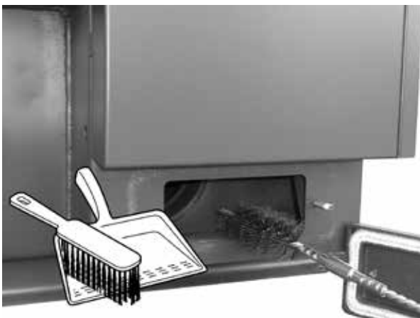
Vorführung der Reinigung des Rauchkanals mit Drahtbürste.
