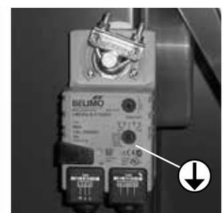
Die Lage der Klappe bei Heizölbetrieb. In diesem Zustand spielt die Abgastemperatur keine Rolle. **Die Klappe ist voll geschlossen.**
