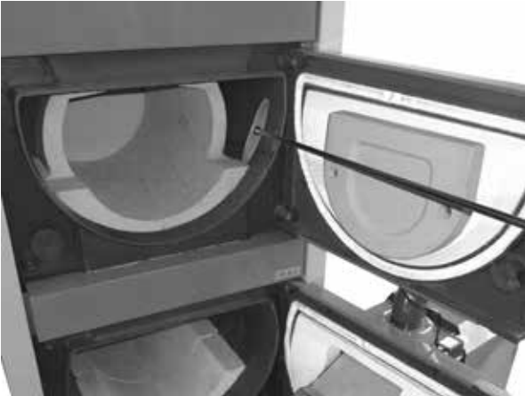
Offene mittlere Kesseltür mit dem Muster, wie die Asche durch das Schüreisen gereinigt ist
