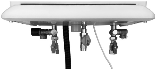
Abb. 11: Hydraulische Heizkreisanschlüsse inkl. Sicherheitsventil sowie KFE-Hahn
